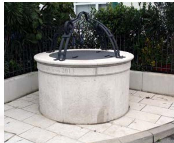
napis: »obnovljeno 2013«. Postavljen je na kamniti ploščadi. Jašek je betonski. Vodnjak je globok 17,80 m in je pokrit z dvodelnim kovinskim pokrovom.
